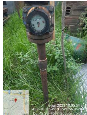
Foto No. 4 Medidor Instalado
